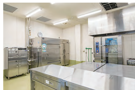
厨房 (スチームコンベクション・真空冷却機)
